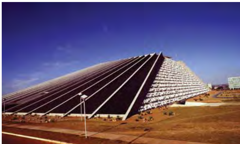
Figura 1 - Athos Bulcão. O sol faz a festa , 1966, relevo em concreto pintado, 21.50 x 128 m.
